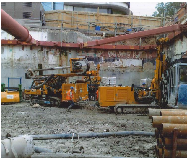
MINI PILING WITHIN BASEMENT
